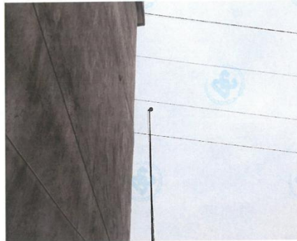
图 17: △16#车家村大徐湾, 临阳大公路第一排居民楼第 3 层
