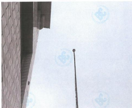
图 5: △4#双铺村黄家墩, 临线路第一排居民楼第 3 层
