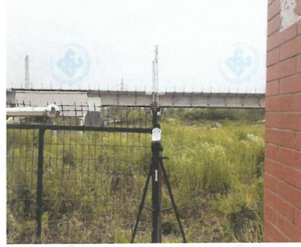
图 8: △7#殷店村殷店街, 临线路第一排居民楼第 1 层外
